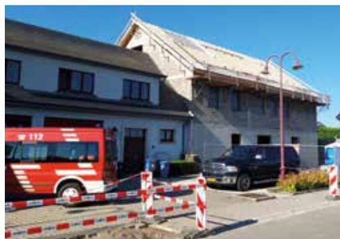
*Gros-œuvre portant achevé - Travaux de charpente en cours*
